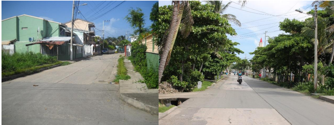
Foto 2-2. Deficiencia de andenes
