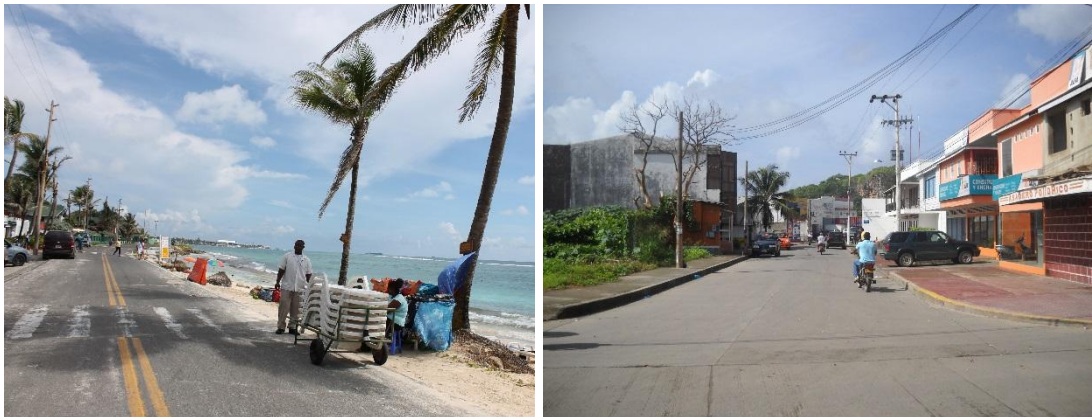
Foto 2-12. Señalización horizontal San Andrés
