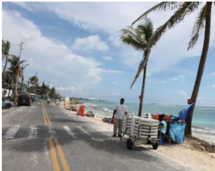
Foto 2-2. Ejemplo de señalización deficiente
