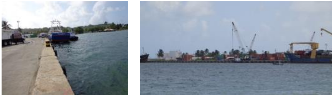
Foto 2-11. Línea de defensas en el muelle
